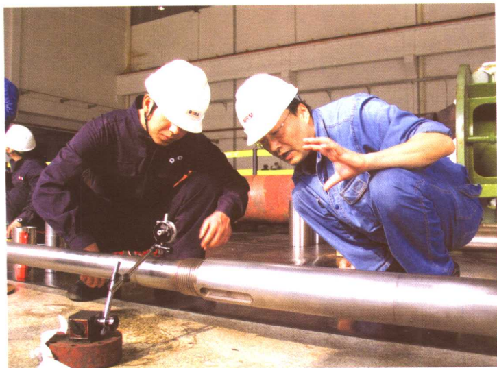
■ 凝结水抽取泵解体检查
