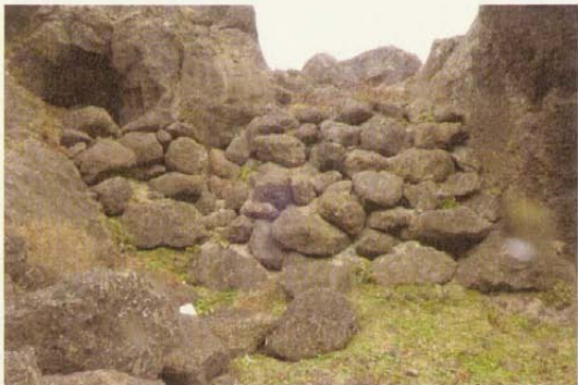
司機A等，第一次挖金所填築出的石牆。(2014.11.10)
