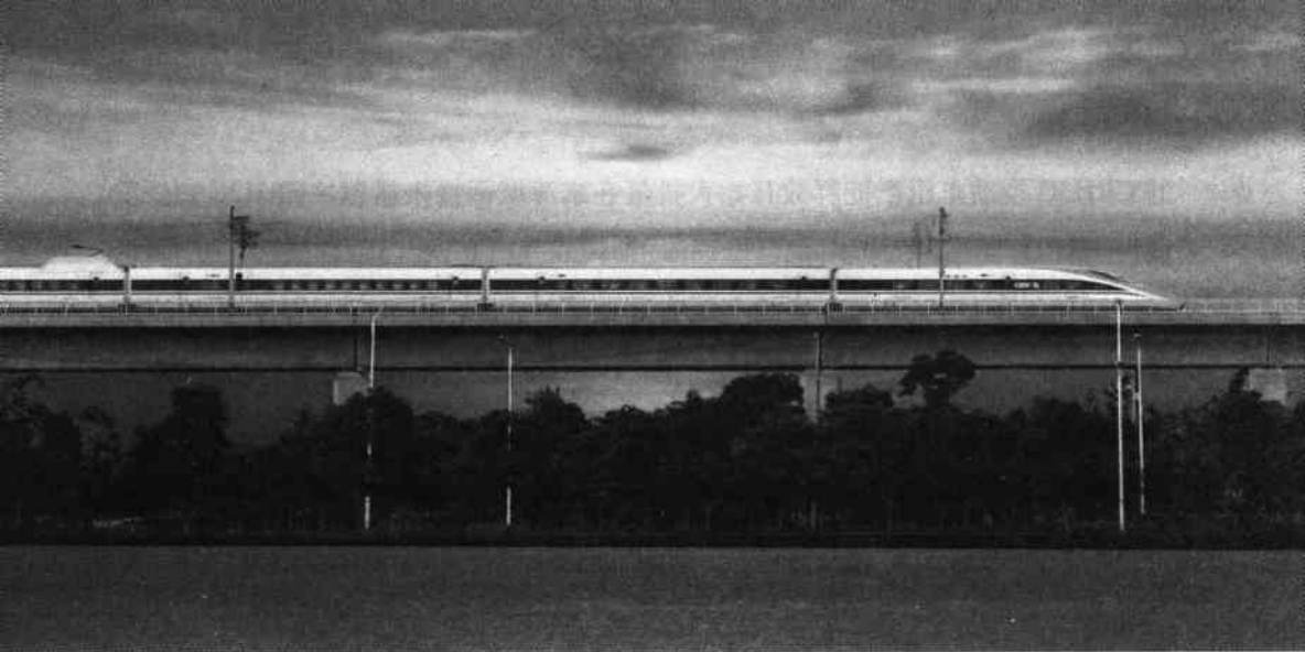
CRH380A 型高速动车组驶过阳澄湖大桥。
