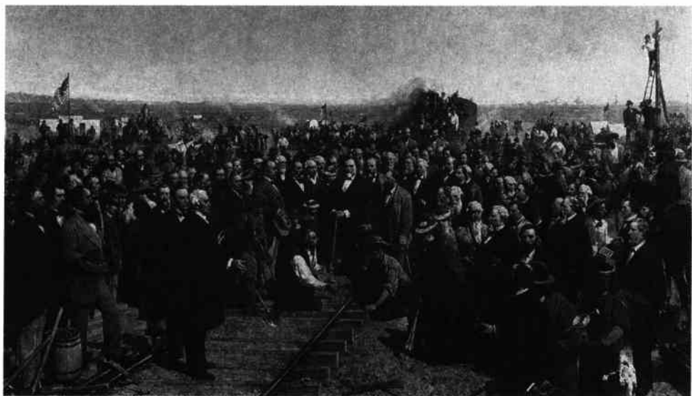
美国跨州铁路全线贯通。
