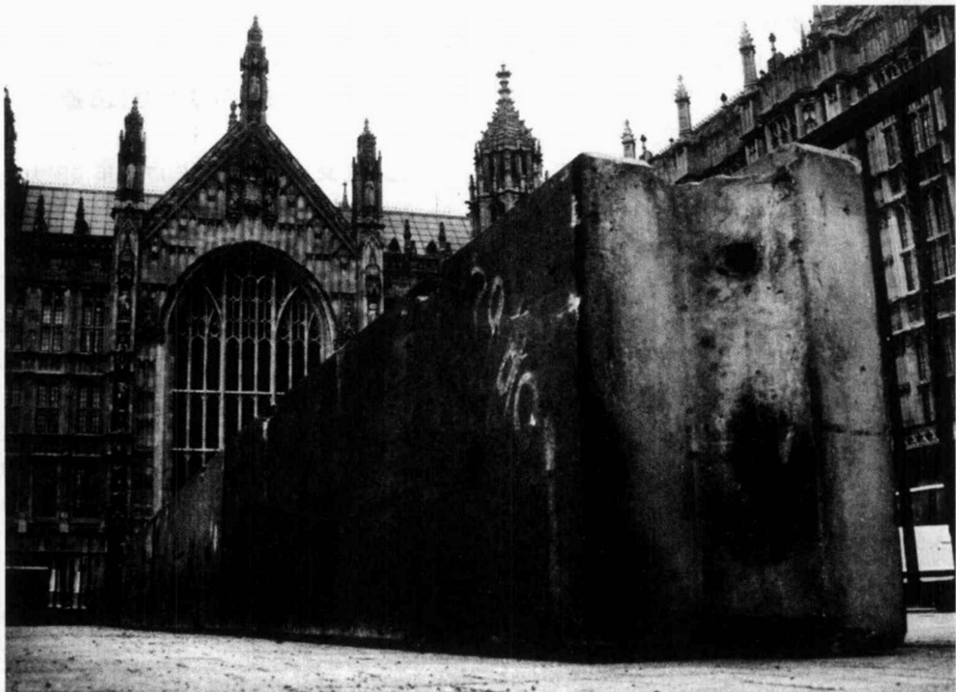
巨型混凝土障碍物被设置在议会大厦 ① 前,试图防御恐怖袭击。
