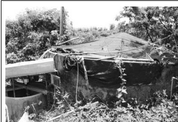
圖 四-27 水泥製貯存槽及抽水設備 說明：研究者於民國九十九年六月六日拍攝於大井。丘陵地上隨處可見的水泥貯水槽，普通貯水槽大約直徑一米，還有更大型可達二米的
