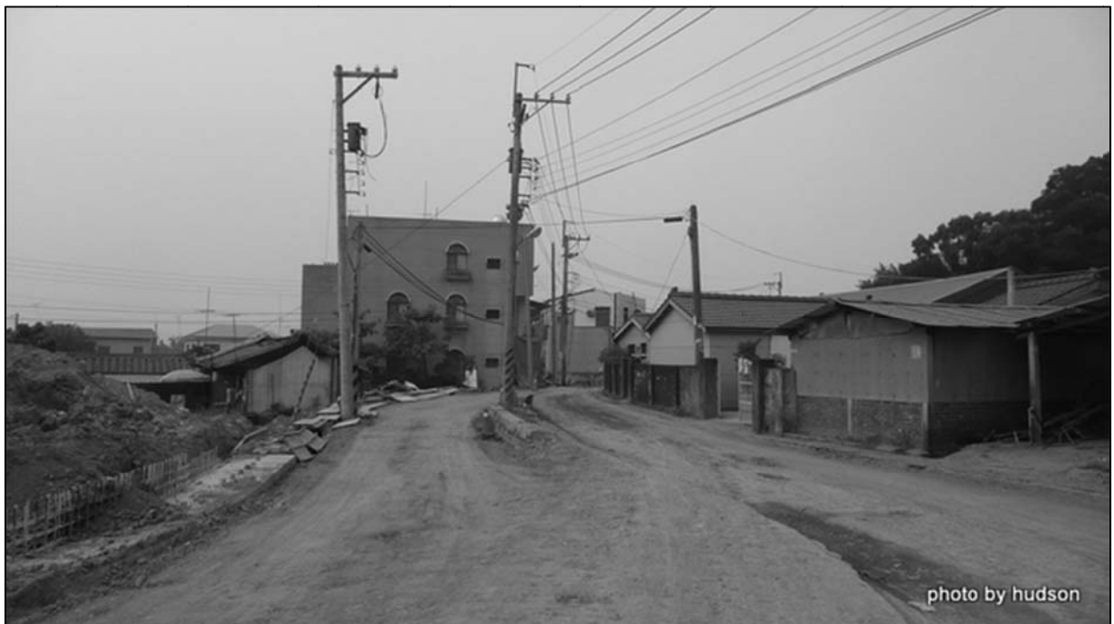
圖 四-68 南 111 縣道大崎庄內拓寬情形
