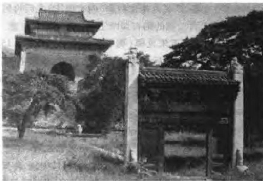
图 2—28 明永陵二柱门及明楼
