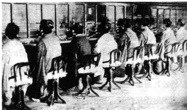
日本初期的女性接線員 摘自《東京の電話》，電氣通信協会
