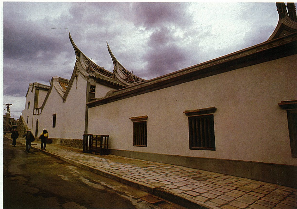
為防漏水重修之後的天后宮。 (攝於1985年)
