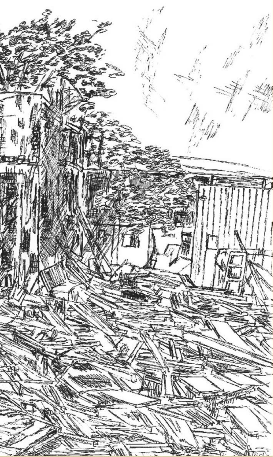
手繪 2015 年 4 月 4 日所攝復興路四段旁拆除後的臺鐵宿舍，目前該區已封閉。（朱書漢／繪）
