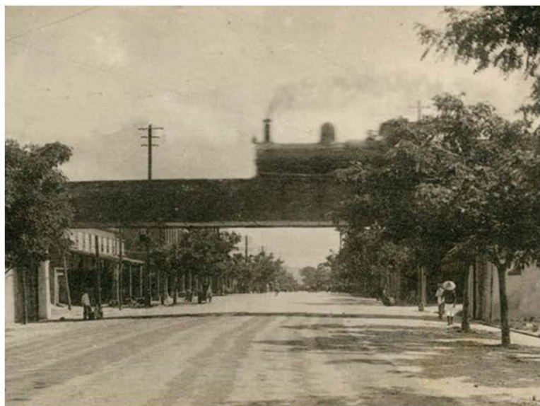
位於櫻町，今民權路與臺中路交會處的鐵橋，許多臺中人常以「火車路空」來形容鐵橋與橋下空間。（遠景編輯部／翻攝）
