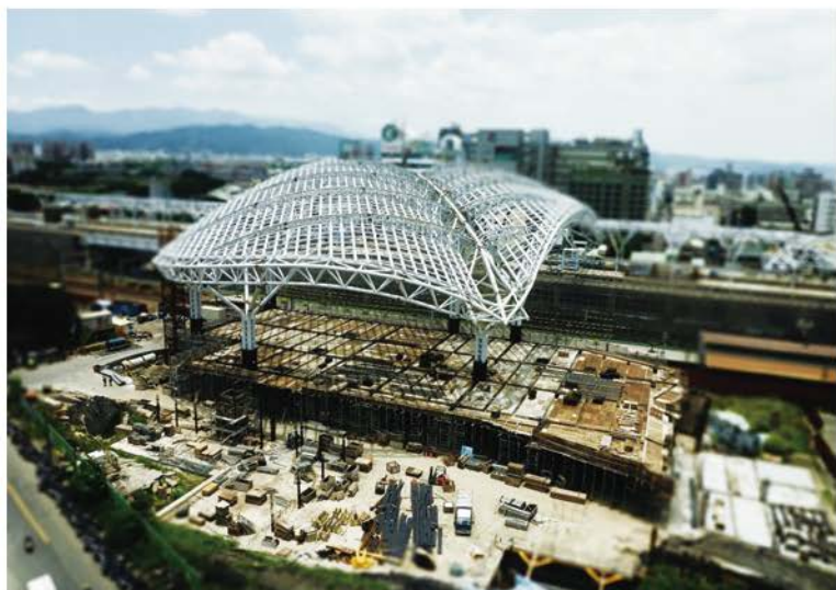
新火車站建造中，攝於 2015年6月19日。
