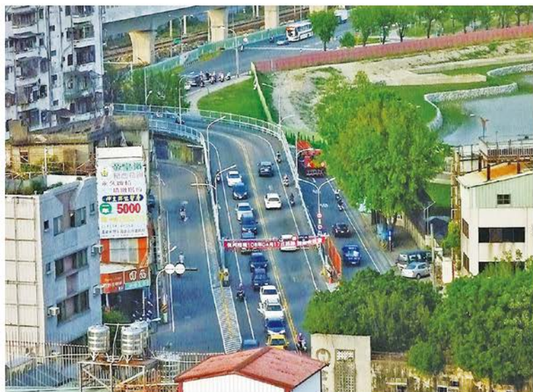
從大魯閣新時代購物中心 11 樓拍攝復興陸橋，足見陸橋的大角度彎曲。
