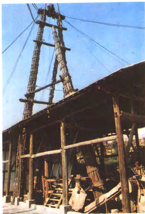
2 四川省自贡市桑海井，世界第一口超千米深井。清道光十五年（1835）以冲击式顿钻法钻成，深1001.42米。 (自贡市盐业历史博物馆谢奇筹摄影)
