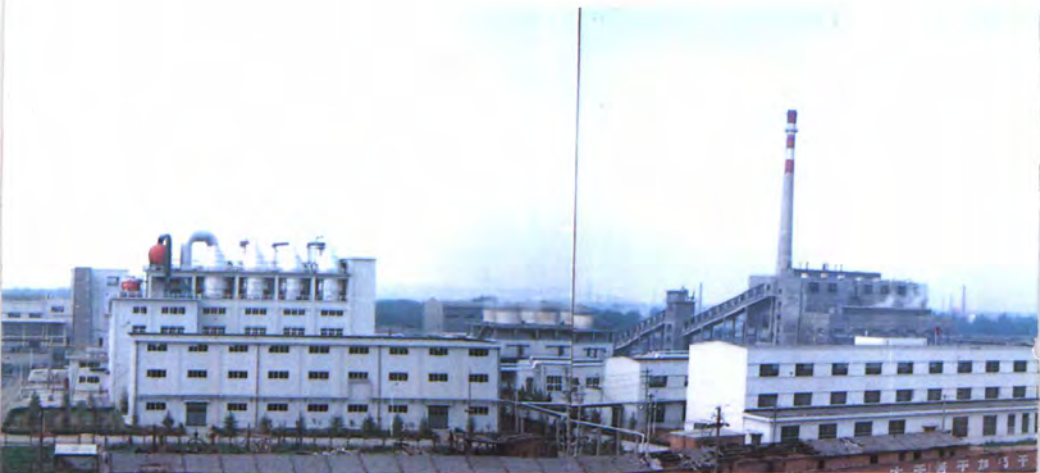
26 河南省平顶山制盐厂年产30万吨的真空制盐装置和发电厂。 (河南省盐业公司供稿)
