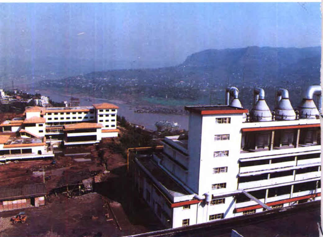
25 建设中的四川省万县市川东盐厂,真空制盐,年产30万吨。 (川东盐厂供稿)
