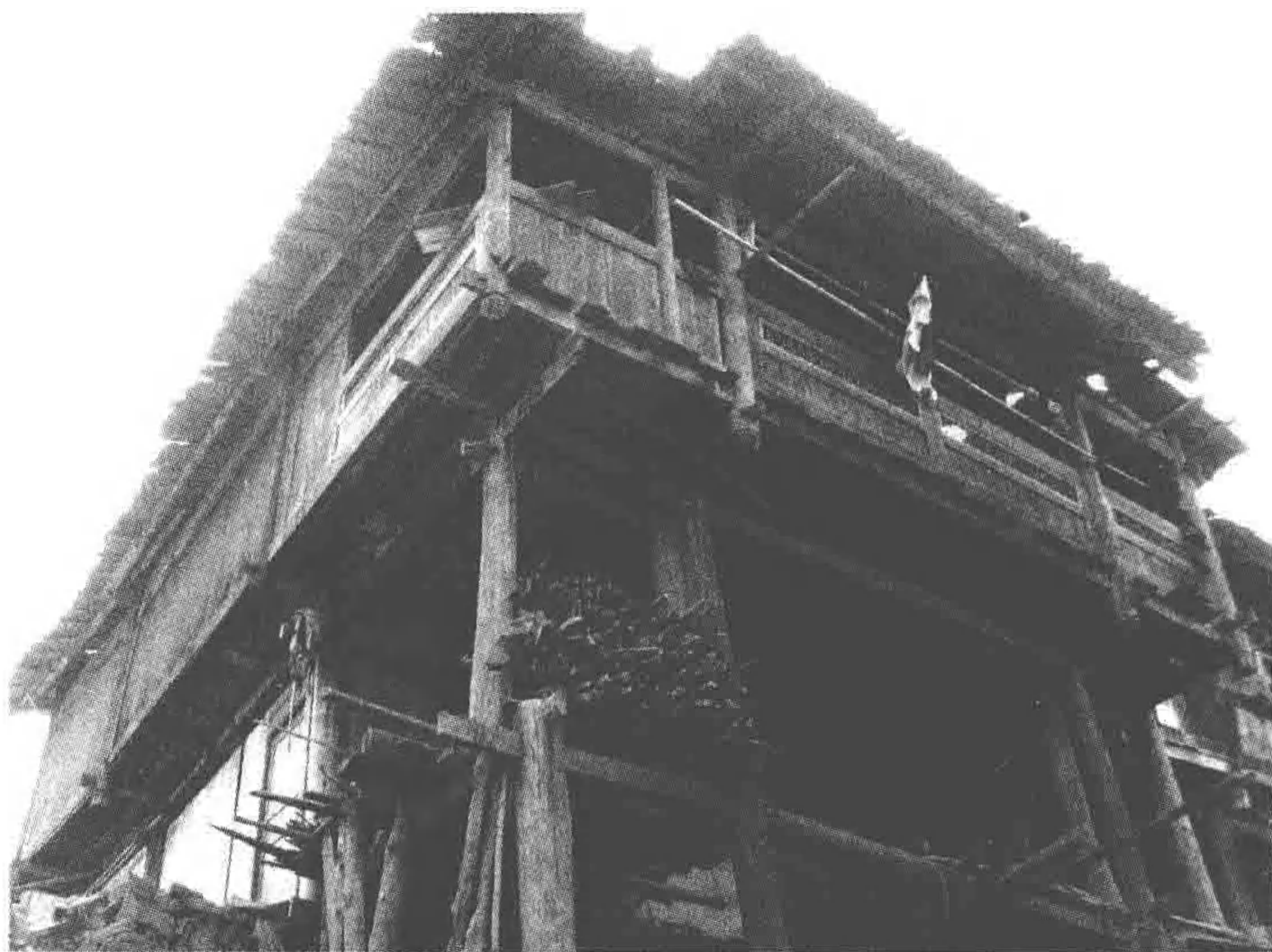
图 1-6 占里的吊脚楼
