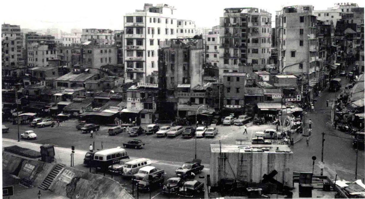
1968年東正道和東頭村道交界處的城寨一角（上圖），只有幾座超過八、九層高的建築物。雖然有明顯的失火風險，但令人詫異的是，像1970年火災（右圖）那種祝融肆虐的情況卻很少發生。
