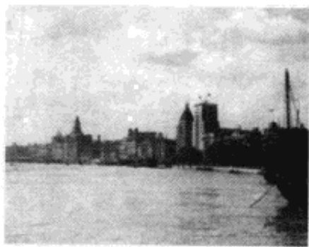
图 3.8 30 年代末,中国银行(最高方顶楼)已建成(1937 年),沿江都是码头,最左有尖塔的大楼为海关大厦
