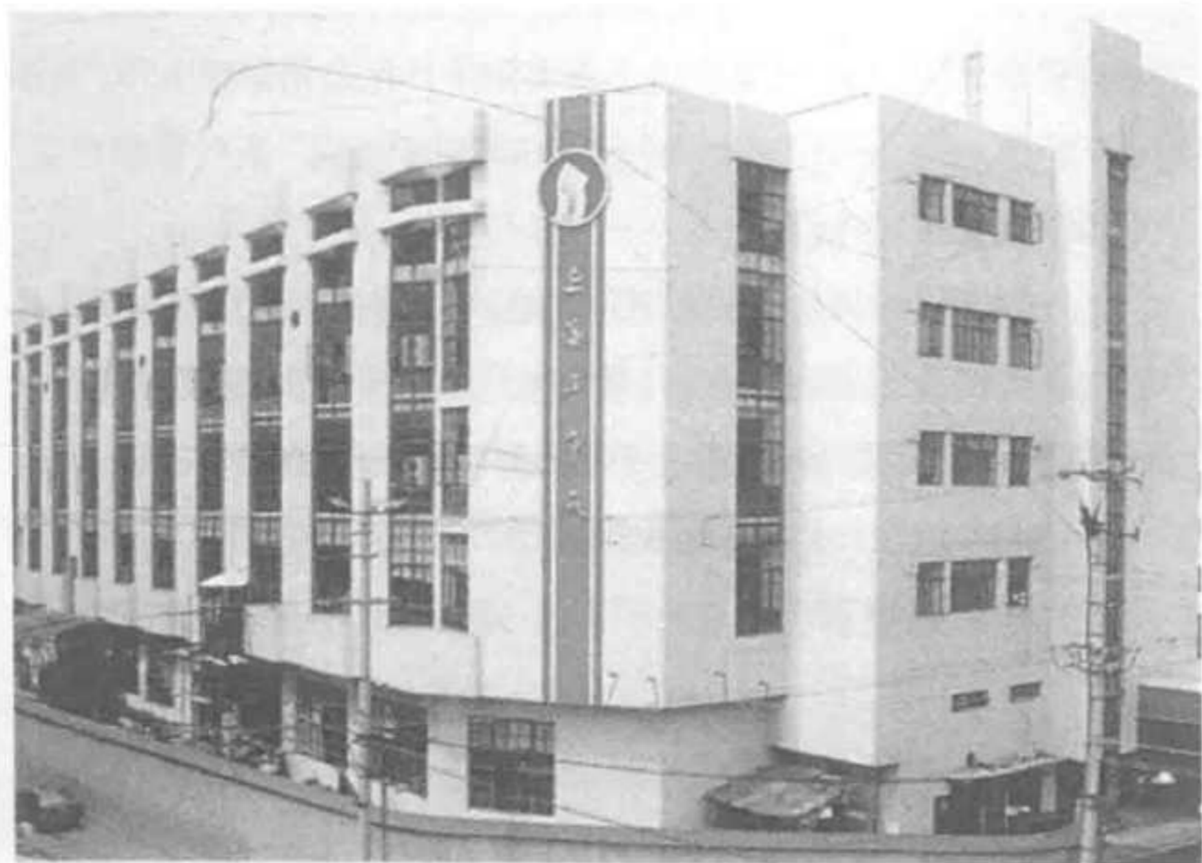
位于安远路的上海牙膏厂旧址
