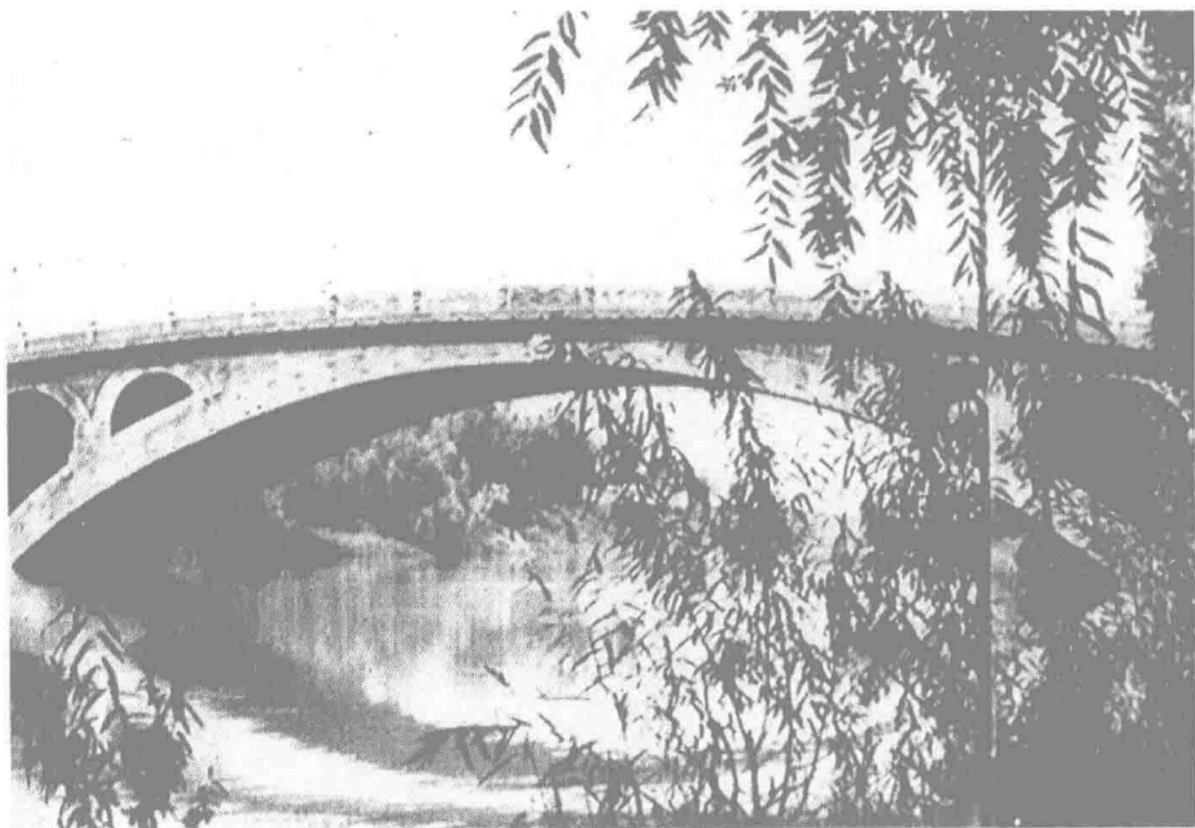
插图 12. 李春的安济桥,所有文明中最古老的弓形拱桥,位于河北省赵县,建于 610 年。
