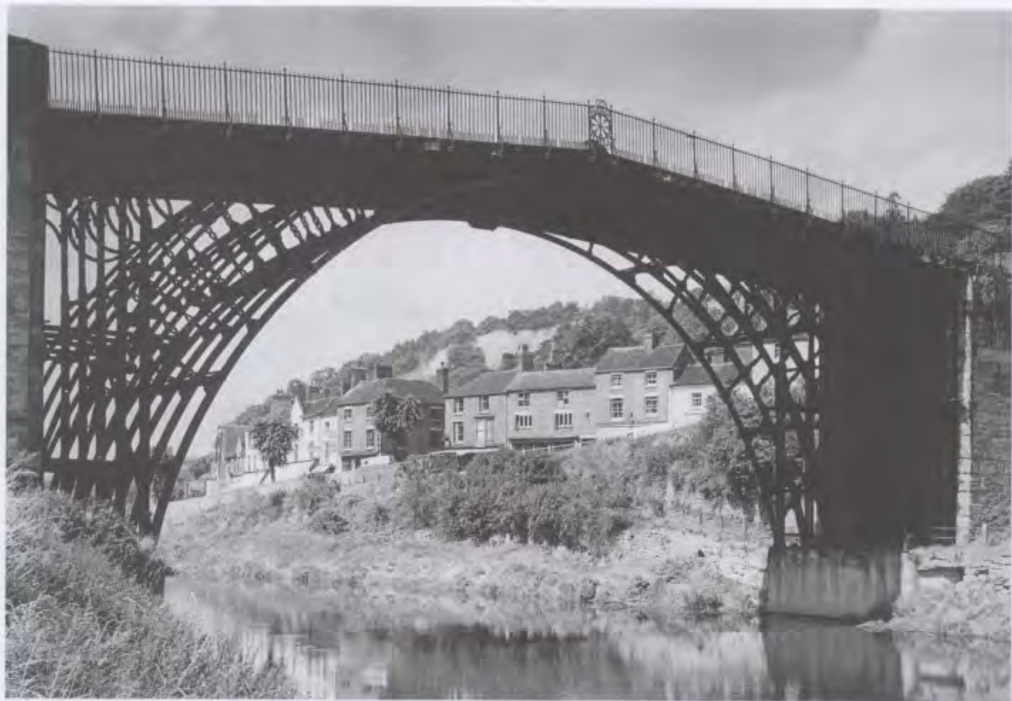
28-4 达比田和普利查德。煤溪山谷大桥(跨越第七大河的第一座铸铁大桥)。公元1776-1779年。全长30.5米。
