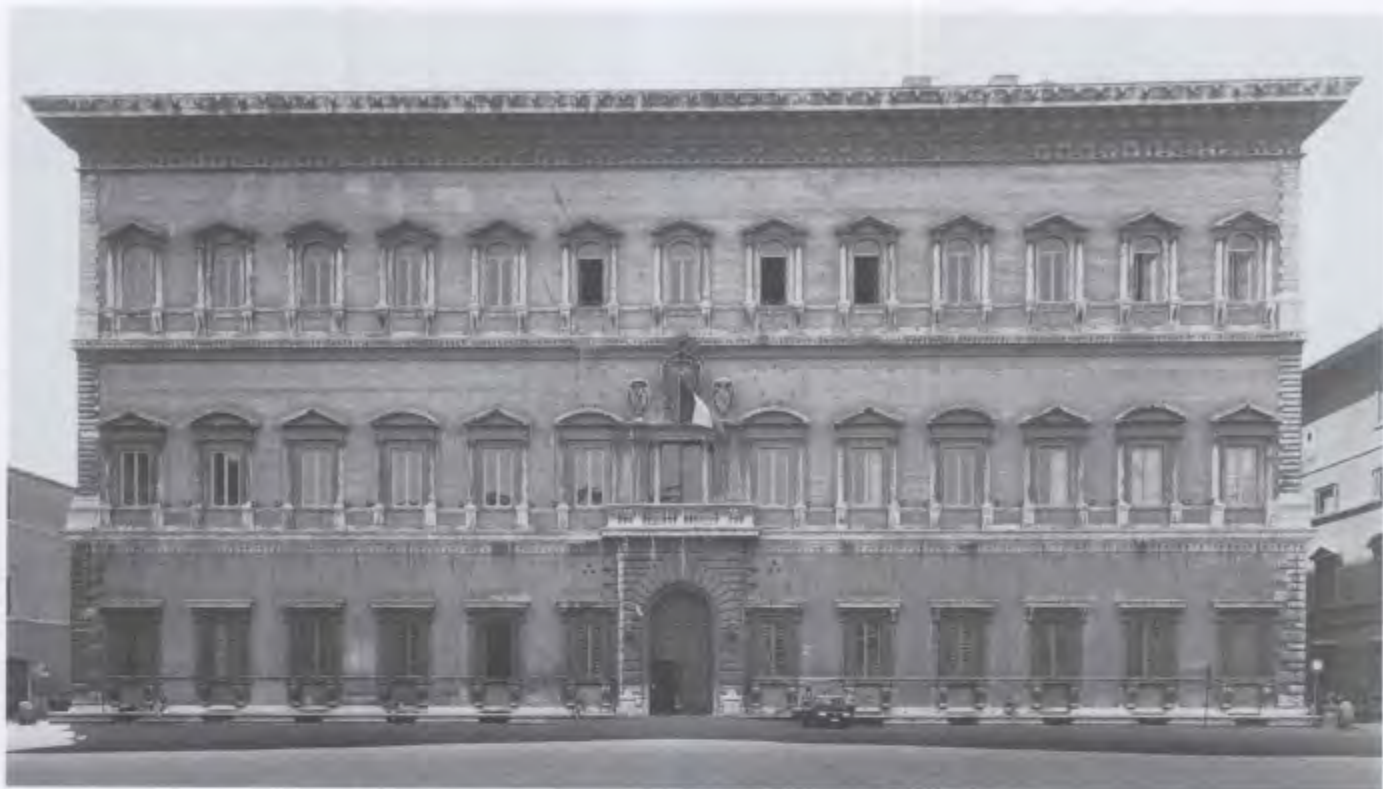
22-23 小安东尼奥·达·桑加洛，法尔内塞宫（西北立面），意大利罗马，约公元1530—1546年。
