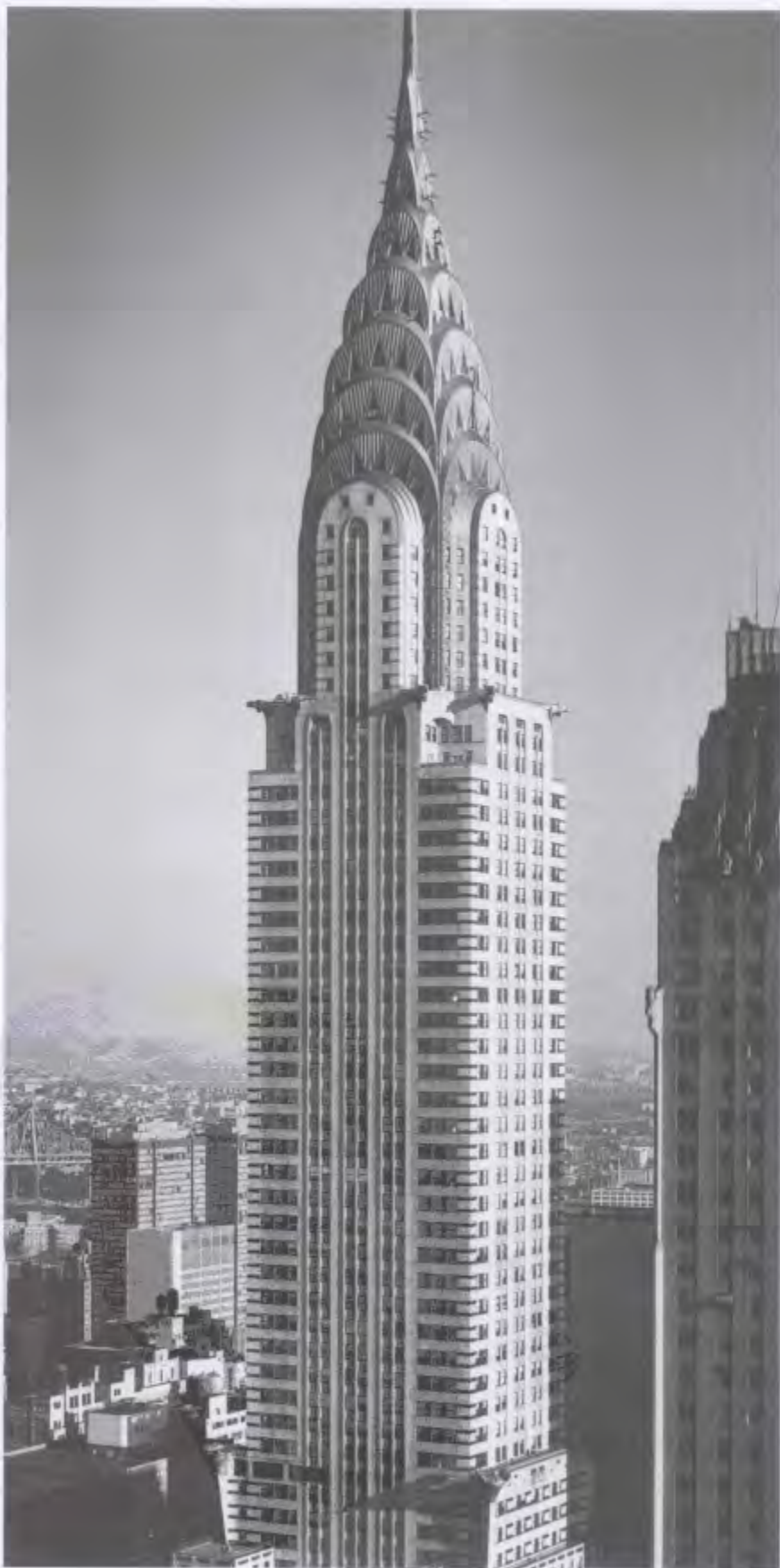
33-66 艾伦·克莱斯勒大厦，不锈钢尖顶，公元 1928-1930 年。总高 320 米。
