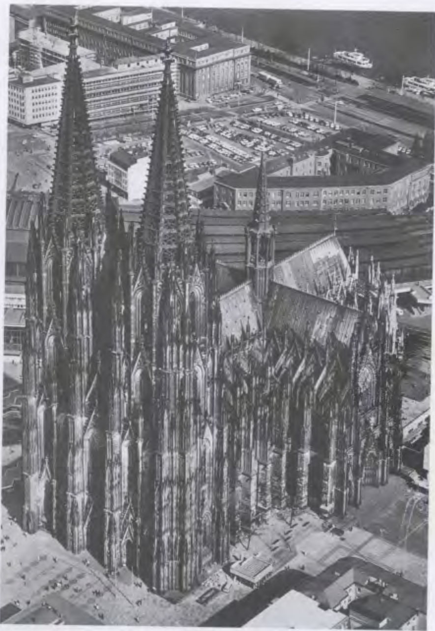
18-46 科隆的格哈德·科隆大教堂（从西南方向鸟瞰的景象），德国，科隆。始建于公元1248年。中殿、立面与塔楼完成于公元1880年。
