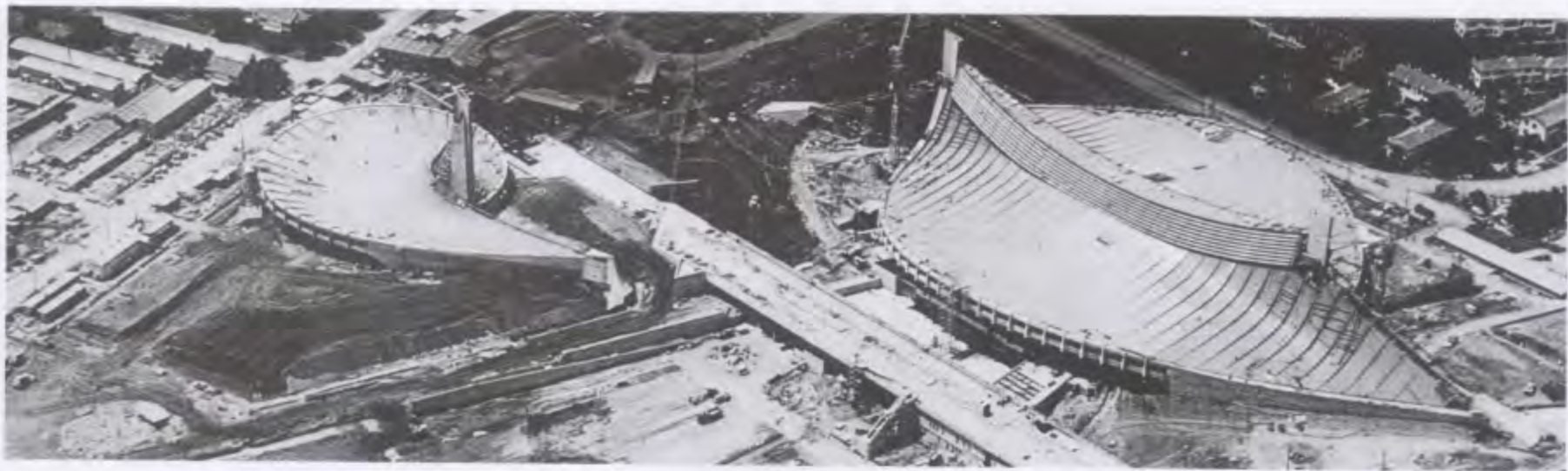
27-18 丹下健三，国家奥林匹克室内运动场，东京，昭和时代，公元1963—1964年。
