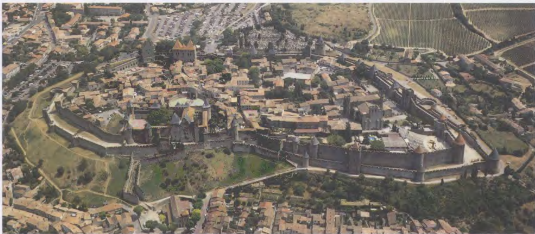
18-29 卡尔卡松尼设防城镇的鸟瞰图，法国，棱堡与塔楼，公元12-13世纪，由欧仁·维奥莱公爵于19世纪修复。
