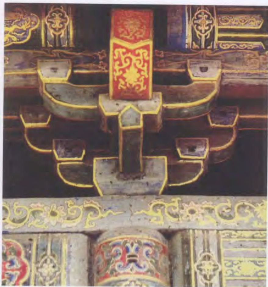
7-10 支撑塔檐的斗拱结构，中国。
