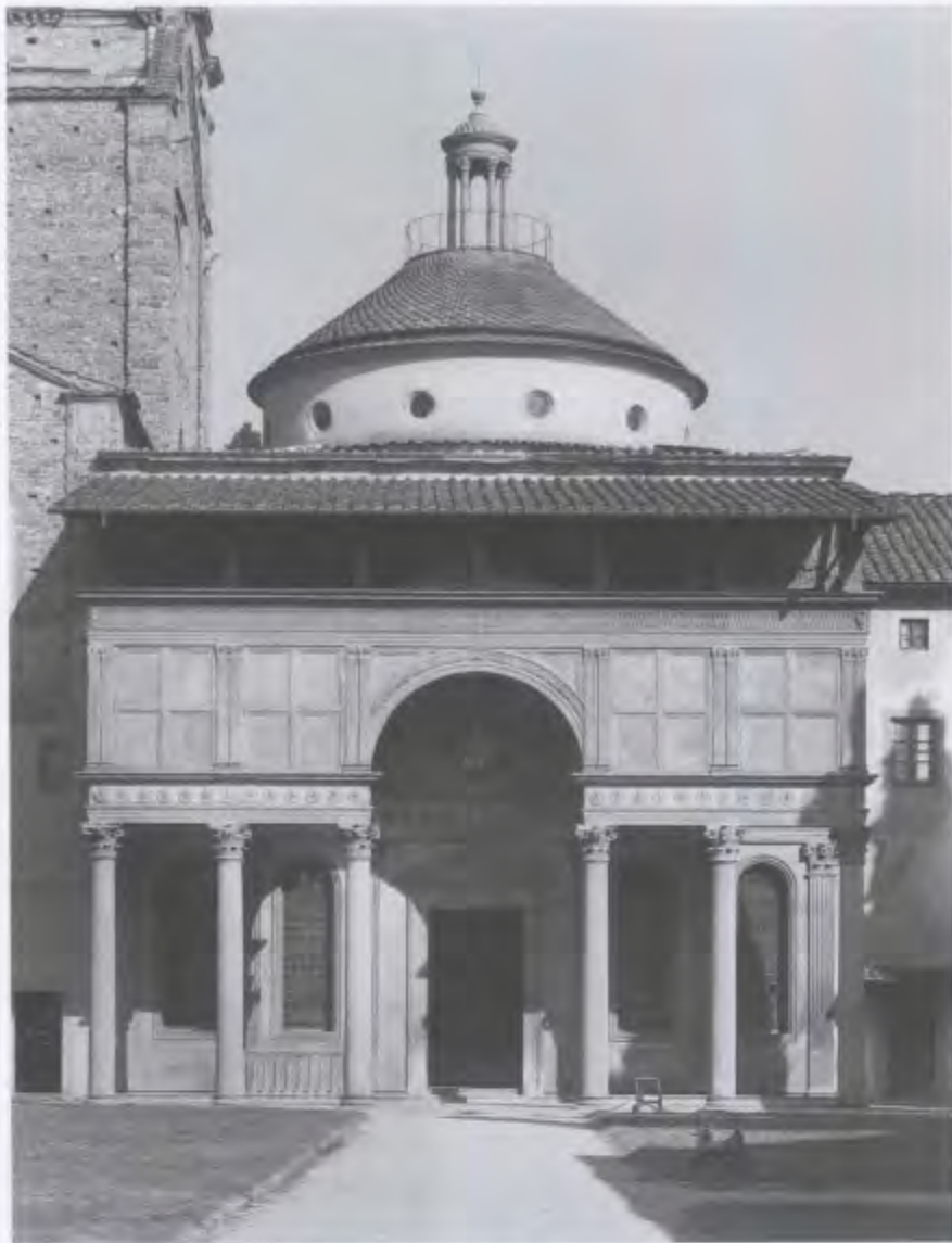
21-17 布鲁内莱斯基，巴齐礼拜堂的西立面，意大利佛罗伦萨，圣十字教堂，始建于约公元1440年。
