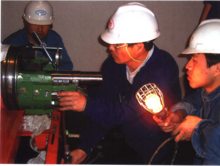
■ 岭澳核电站辅助给水泵检修
