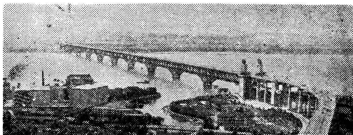
图 2 南京长江大桥。铁路桥长 6700 多米，公路桥长 4500 多米。
