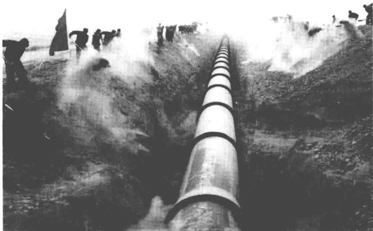
★ 新疆军区某师官兵在西部边疆荒漠戈壁引水工程的建设中，顶着风沙回填引水输水管线。
