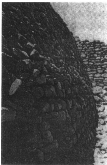
图 15 I号石城南垣内侧的西半部
