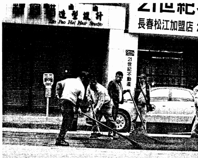
台北街頭賣力鋪設柏油路面的勞工 照片提供：本書作者
