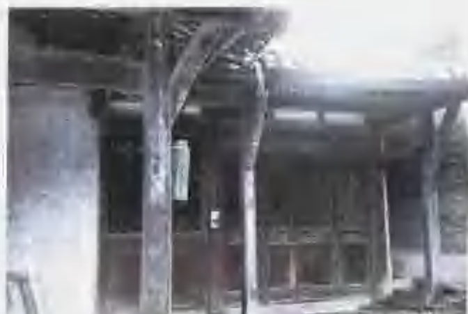
▲ 新都县石板滩残存的廖家寨一角 (方舟摄)
