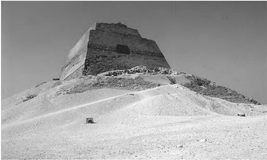
The Collapsed Pyramid at Meidum. (M. H. Feder)
