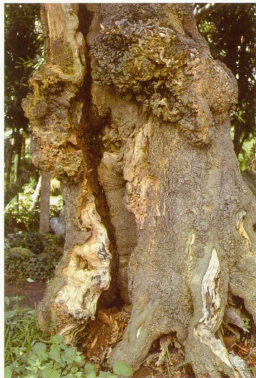
杜英老木腐幹(1990.7.1; 赤水)
