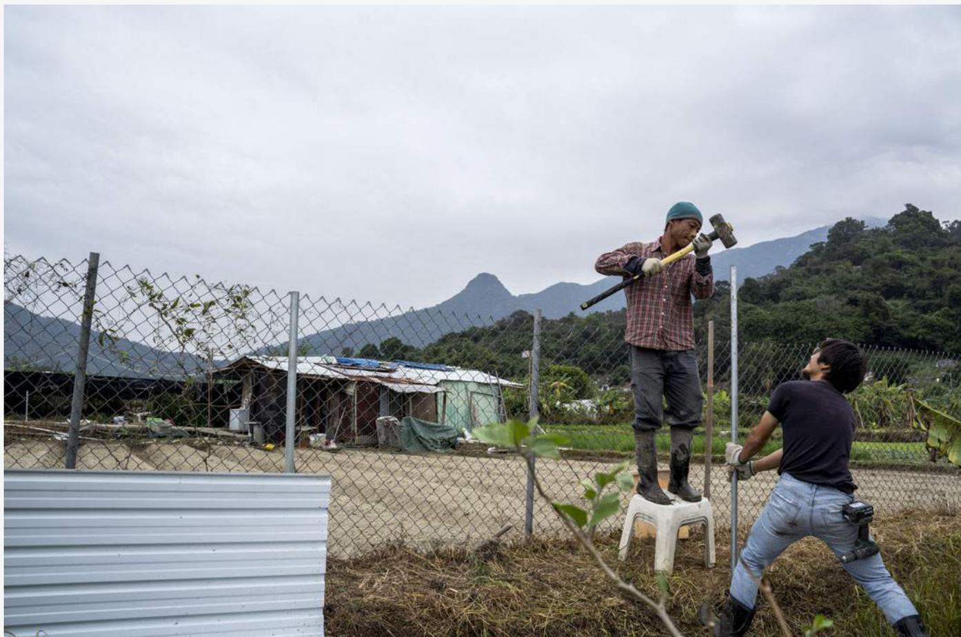
周思中和農友們以不易變形的瓦板、鋅鐵板，在田的周界每隔七呎打下鐵通，再把鋅板修緊在上面，建出一個防豬長城。攝：林振東/端傳媒
