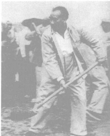
朱德在水库工地劳动
