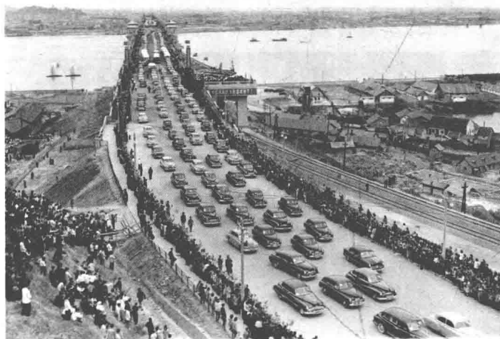
★ 1957年10月15日，武汉长江大桥建成通车。铁路桥长1315米，公路桥长1670米。
