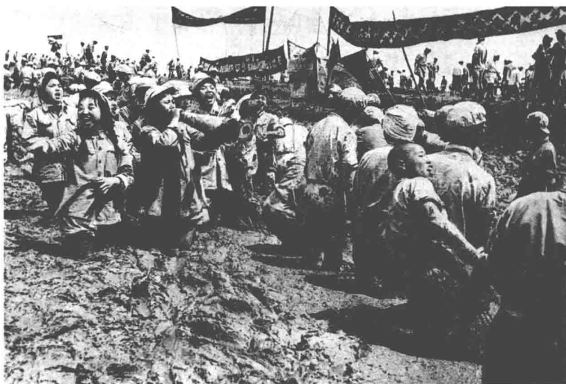
★ 荆江分洪工程工地。
