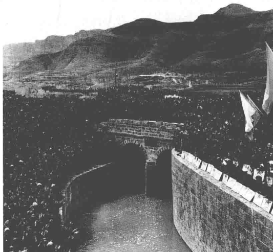
★ 1966年，林县人民在总干渠分闸工地庆祝红旗渠一期工程竣工。
