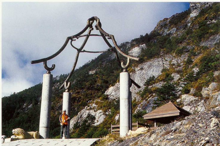
東壩口不當的人工建物，破壞自然景觀(2005.10.22；台20-147.5K)。
