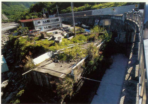
上圖：台20-93.6K之紀念拉瑪達 星星牌(2005.12.11)。 中圖：台20-95K之撒拉阿塢新大 橋(2005.5.23)。 下圖：撒拉阿塢橋旁即舊斷橋(2005. 5.23)。
