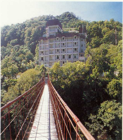
左上圖：新修建天龍吊橋(2005.11.12)。
