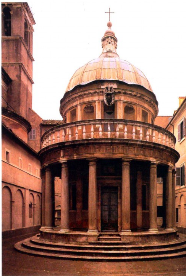
多纳托·布拉曼特 (Donato Bramante) 位于蒙托里奥的坦比哀多礼拜堂, 1502年 罗马
