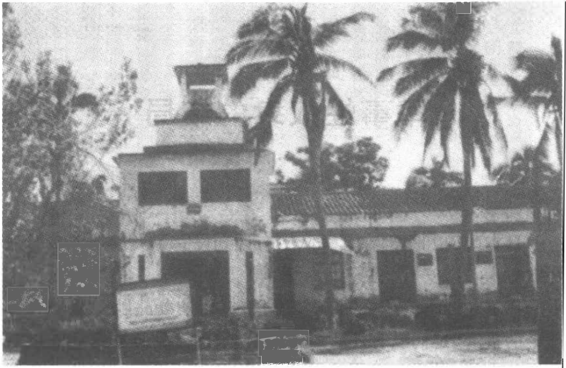
图 62 1940 年侵占海南陵水的日军开始筹建军部,次年建成。军部有三幢日式高脚屋式水泥建筑,最高为五层建筑。图为现存的一幢营房,顶部是指挥台的哨所。(龙建武摄影)
