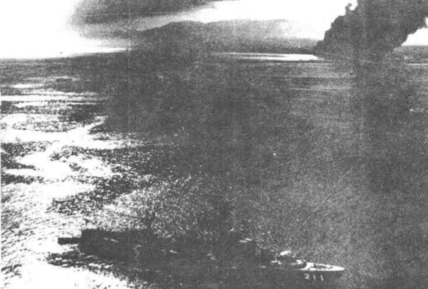
不断燃烧着的新泻市昭和石油罐群和正在前去进行抢救的自卫舰《五十铃》号。油罐群燃烧了三十个小时才好容易控制住火势。摄于新泻地震
