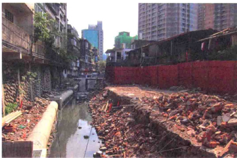
圖 2.1 瑠公家園進行拆除工程中的景象。（吳振廷攝）
