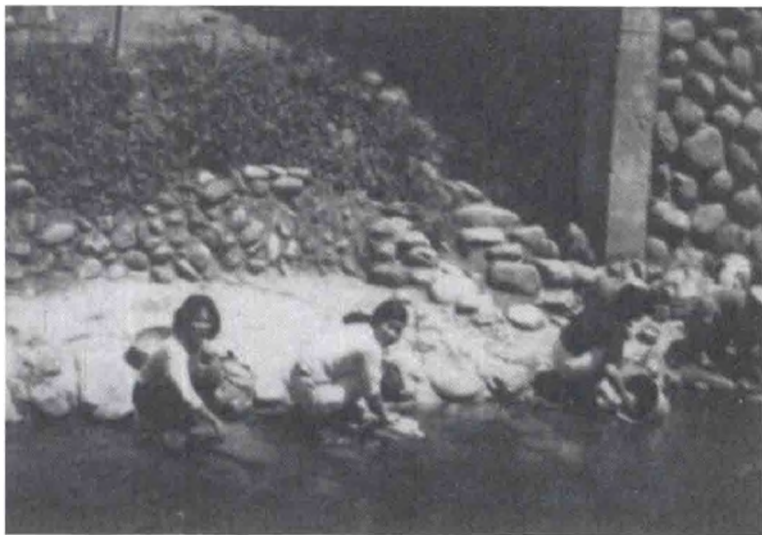
圖 2.3 昔日婦女在吊腳樓前的圳道洗滌衣服。 （瑠公家園提供）
