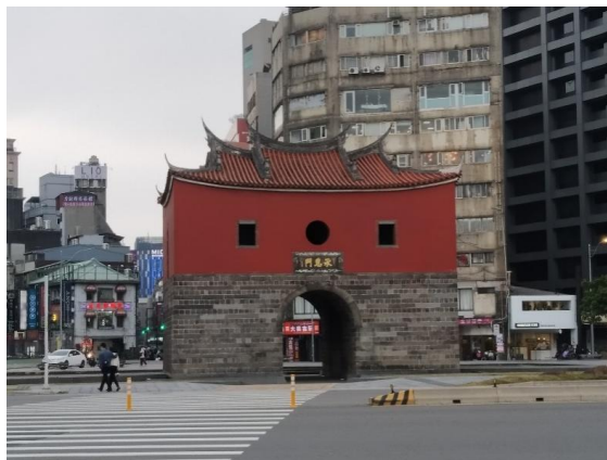
图 5-1：北门（承恩门）保留了最原始的面貌。
