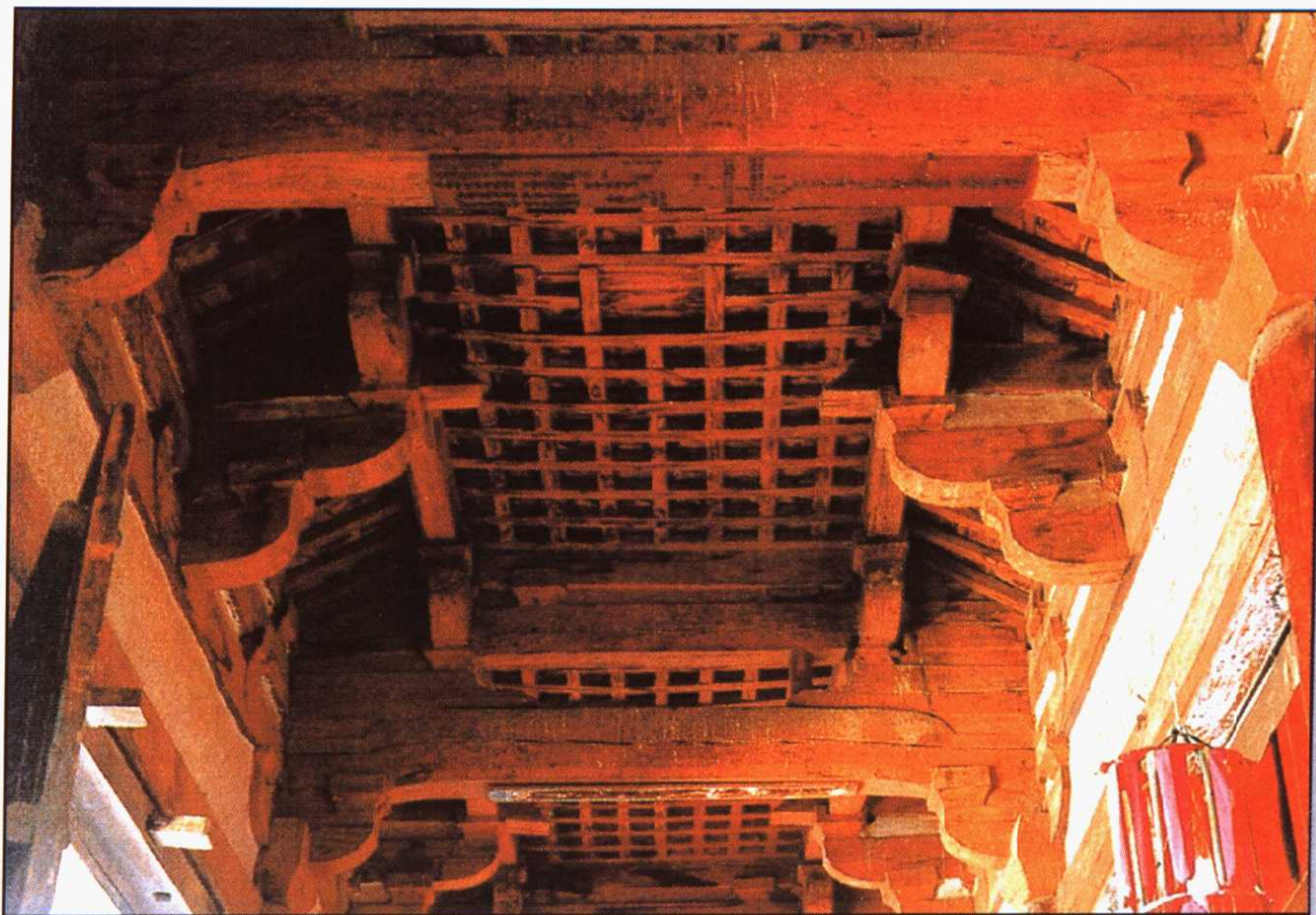
彩图十一 佛光山正殿外槽梁架
