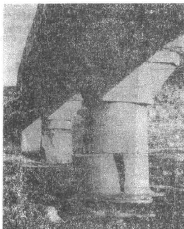
图 13.4.8 海城地震赵家堡西河铁路桥 3 号和 4 号墩震害
