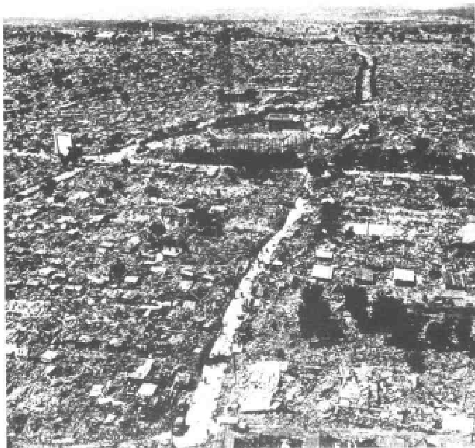
图 5.4.16 唐山地震极震区震害全貌
