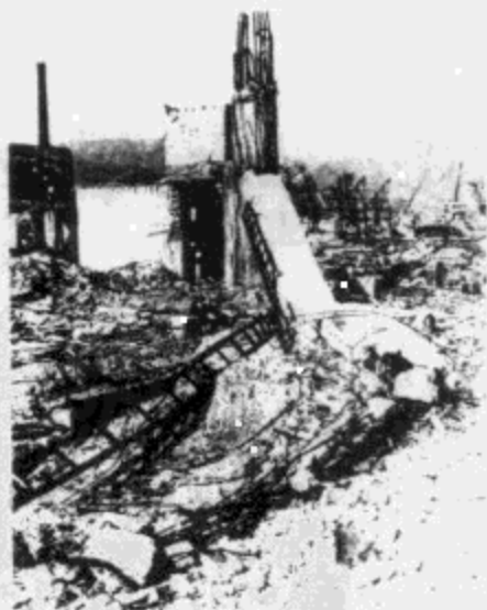
图 3.11 离广岛爆心投影点 540m，高约 20m 的圆形钢筋混凝土烟囱，由于重量较轻，在离地面约 5m 处被冲击波折断
