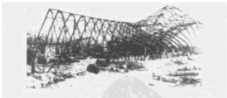
单层轻型钢架建筑部分受冲击波破坏,由于随后起火而进一步塌垮(离广岛爆心投影点 1 280m)。
