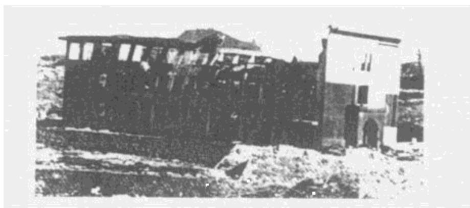
图 3.6 建筑物朝爆炸点一面水平受力被破坏情况 (离长崎爆心投影点 640m)
