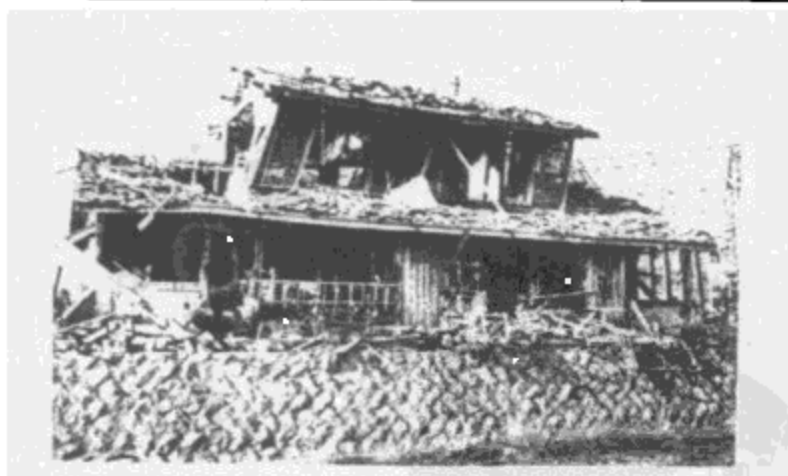
图 3.4 广岛木架建筑核袭击后严重倾斜(离爆心投影点 1600m)
