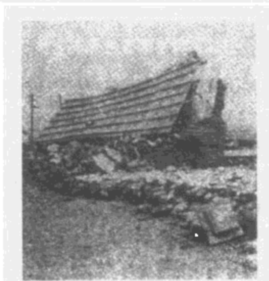
图 2.15 砖砌的低层楼房在超压大于 26\text{kPa} 作用下遭到严重破坏
