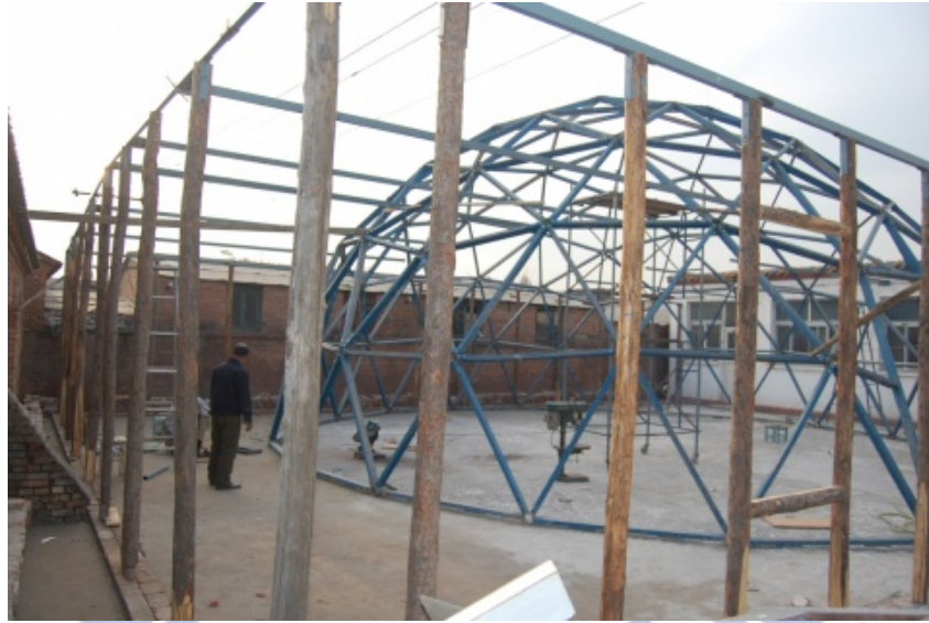
圖 24：搭建中的新工人劇場。(孫恆攝，2008)
