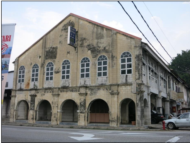
照片 5-9 實得叻公司位在務邊的舊址
