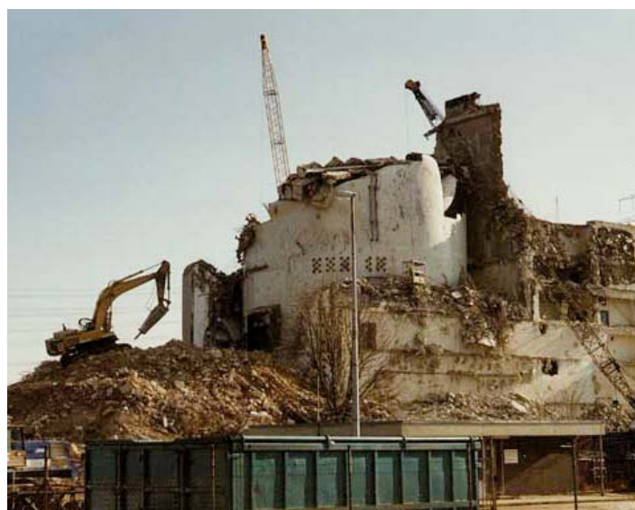
Abb. 17: Konventioneller Abriss der äußeren Gebäudehülle des Kernkraftwerks Niederaichbach
