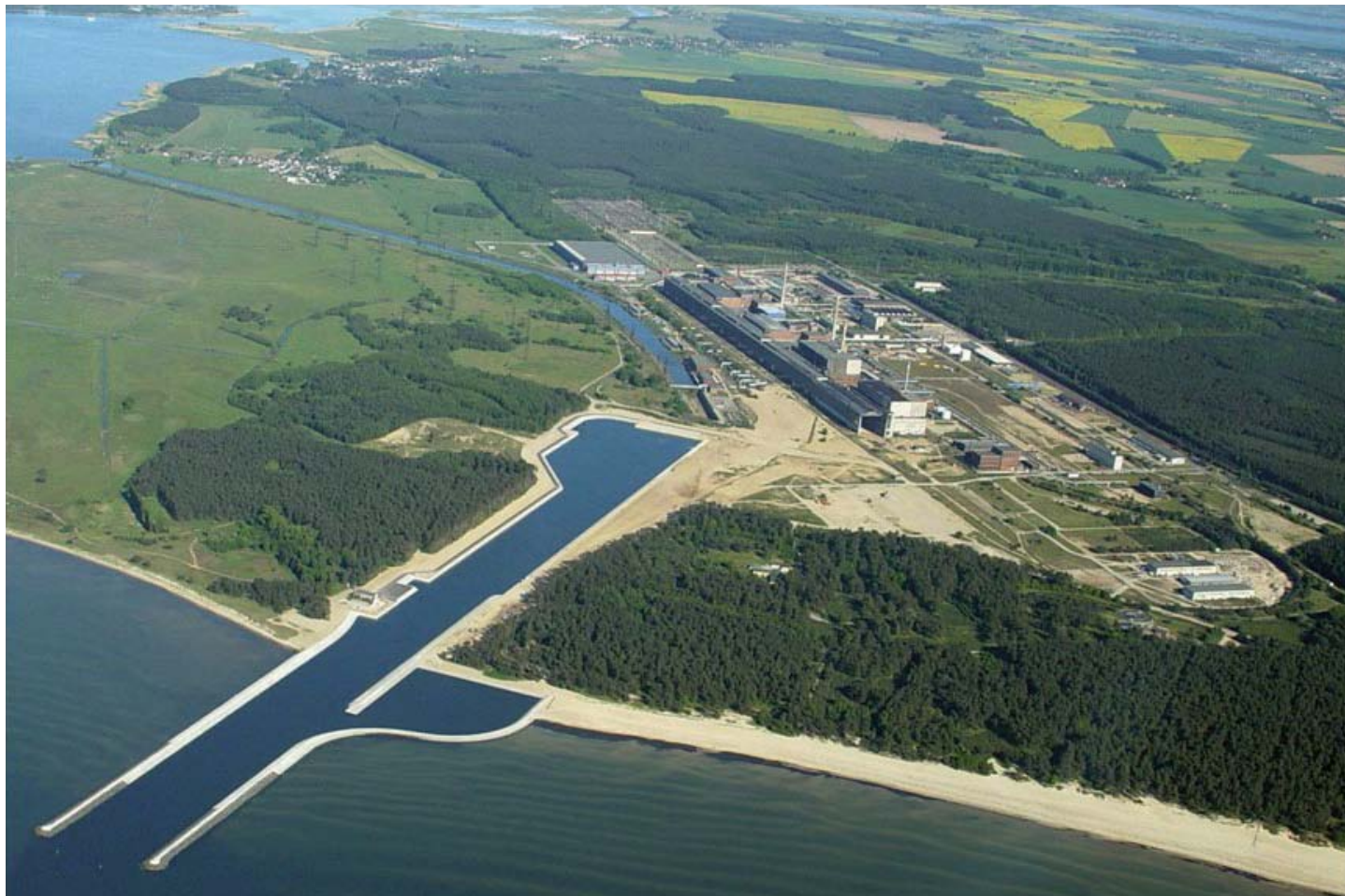
Abb. 2: Standort des Kernkraftwerks Greifswald
