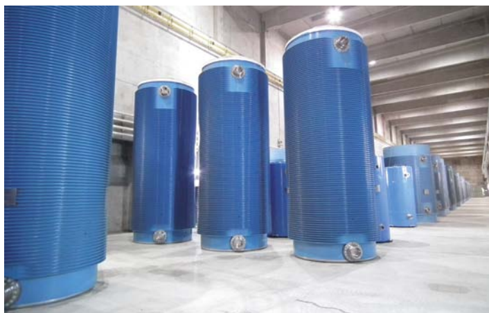
Abb. 40: Transportbehälter im Zwischenlager Nord
