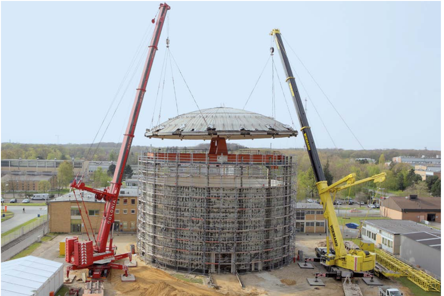
Abb. 6: Abbau des Forschungsreaktors FRJ-1
