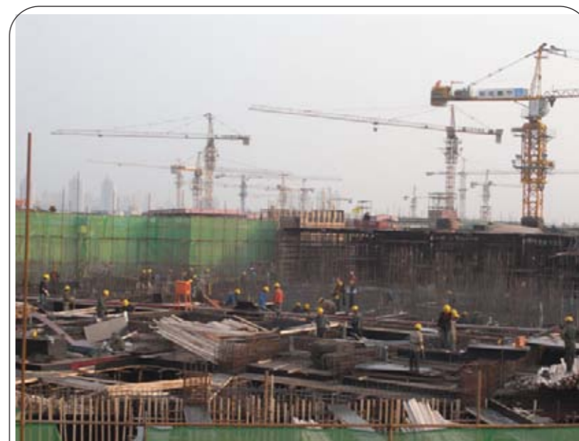
图：塔吊林立的建筑工地
