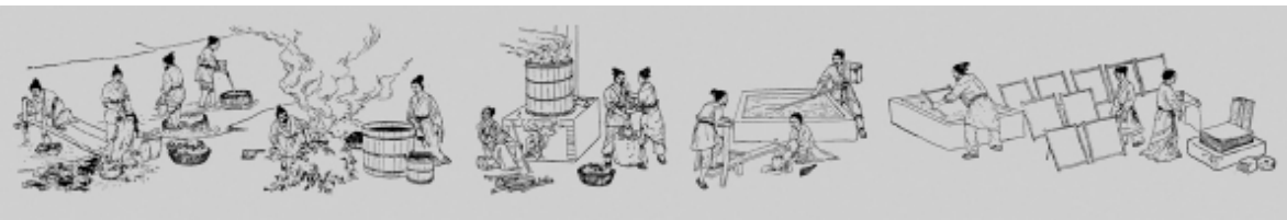
汉代造纸工艺流程图
