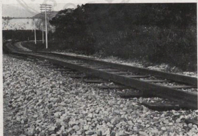
臺中線第八トンネル 北口の鐵道陥没
