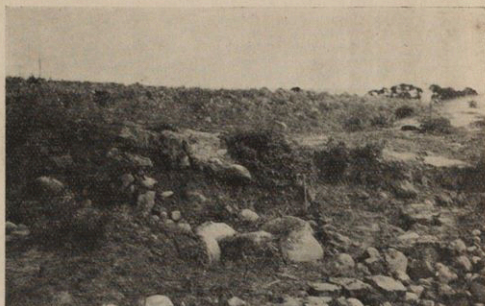
圖十四第 屯子脚斷層の東端部 臺中后里地盤の北東隅、南側約五〇種沈下(早坂) 圖十四第
