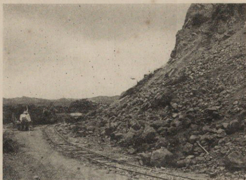
第四十八圖 中港溪中流北岸 北埔小埔北間路傍の崩崖(早坂)
