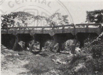
后里、下后里間 旱溪の橋梁
