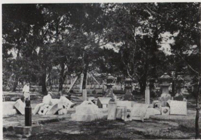
月眉神社の石燈籠の倒壊 (全部南)
