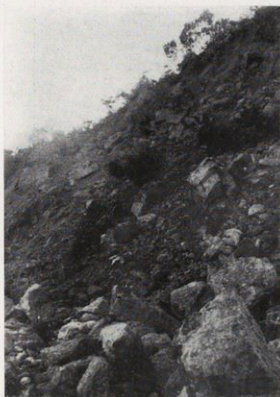
大安溪南岸の崩崖
