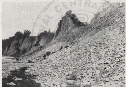
新庄子大甲溪岸の崖崩れ
