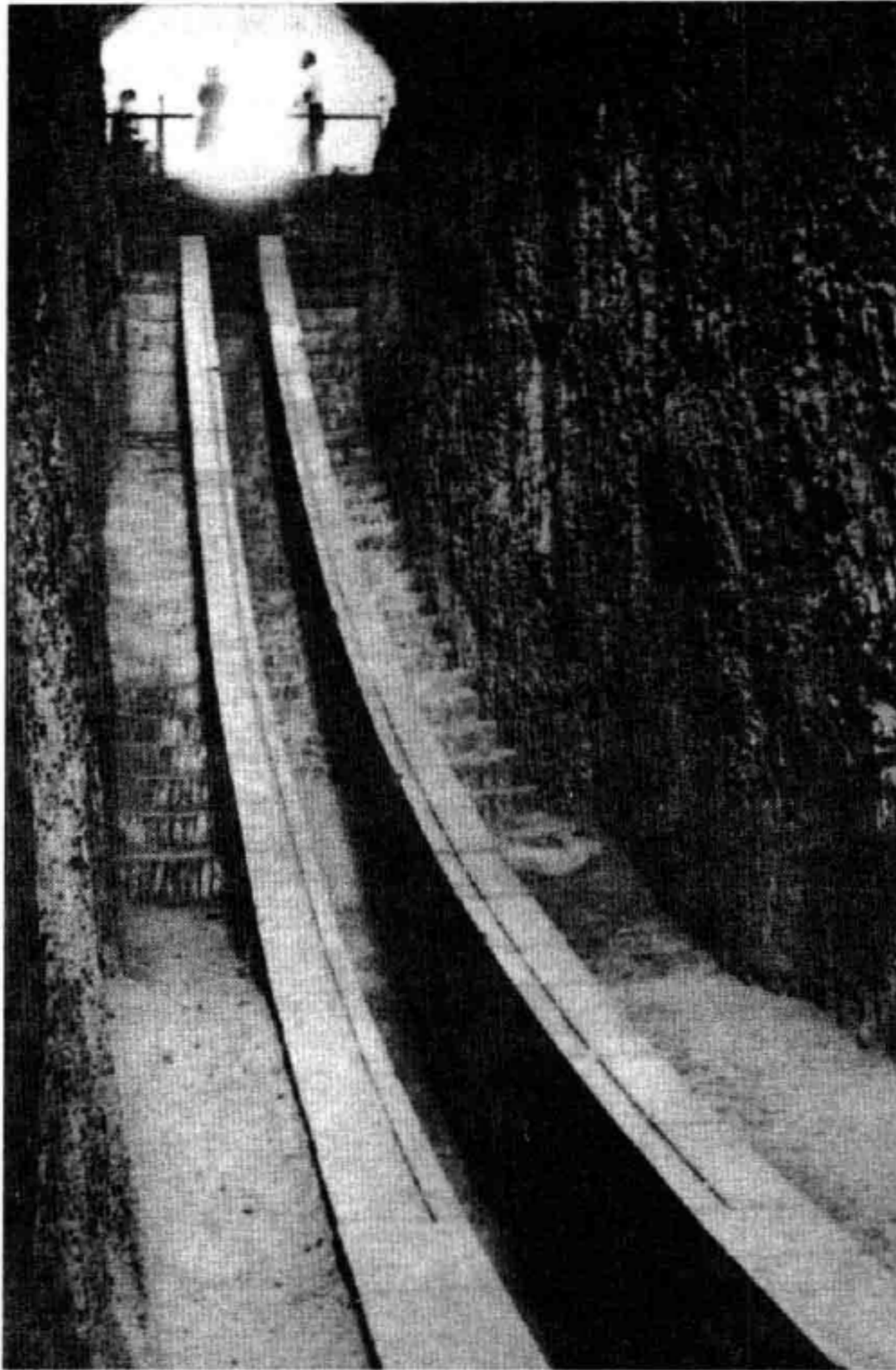
图 8.3 兀鲁伯 (Ulugh Beg) 建造的撒马尔罕的地下六分仪, 用于确定天体穿过子午线时的纬度
