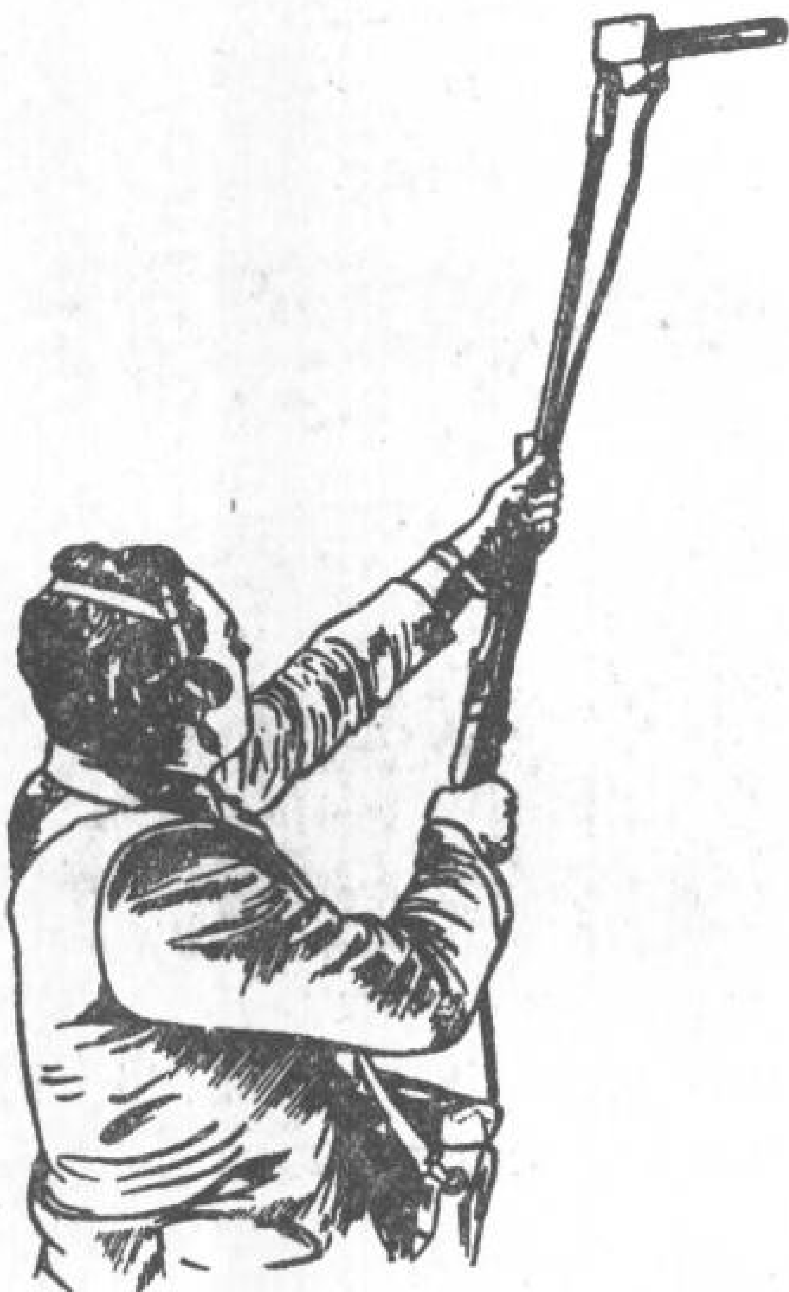
图8 区域找矿用1368A型的 \beta - \gamma 探管
