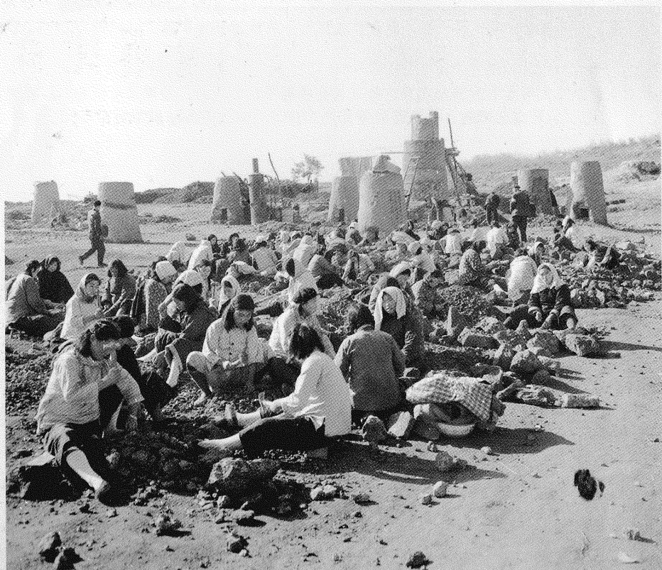
〔圖4〕1958年6月，毛澤東決定，當年應該生產1070萬噸鋼。然後，9月份，再一次確定為1200萬噸。成功的關鍵是在每個人民公社後院建立由村民操作的小高爐，用砂、石、耐火粘土或磚建構，史稱「大煉鋼鐵運動」。
